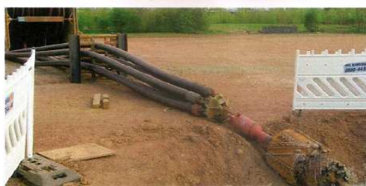
Zdjęcia: bez wykopowe wciąganie (HDD) rur do ochrony kabli – nawinięte na system wielki bęben
